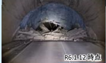
写真① 国道249号中屋トンネル
